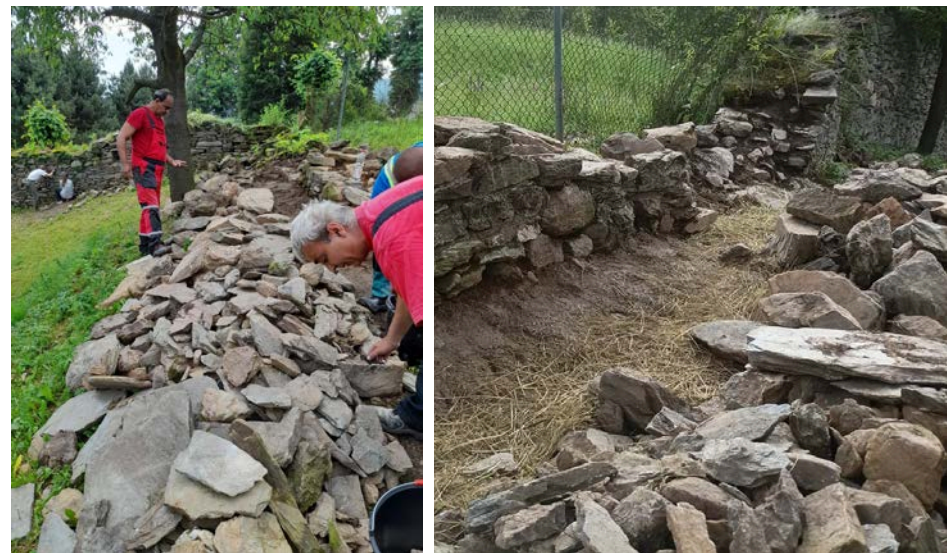
Obnovovacie práce na okolí, gotický kostol Henckovce
